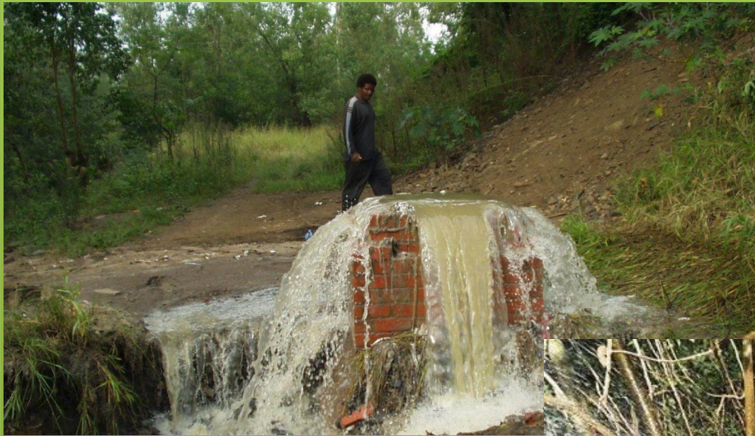
Spilling manholes
